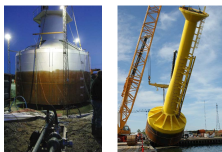
(a) 腓特烈港风机基础 (b) Horns Rev2 风电场桶基
